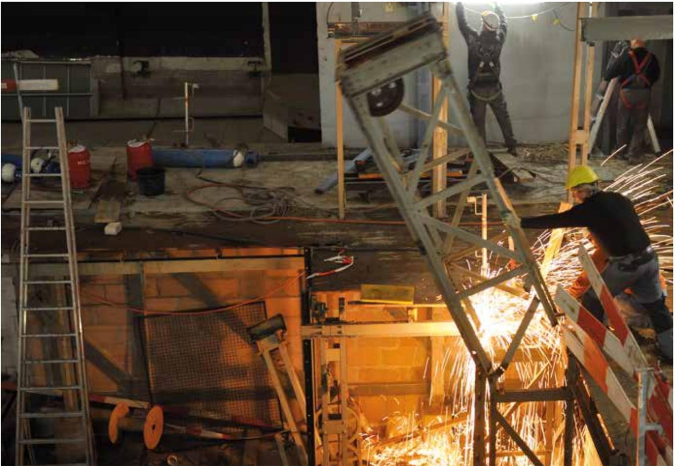
Szenen des Abbruchs: Stützturm der alten Unterbühne im Norden wird zerlegt
